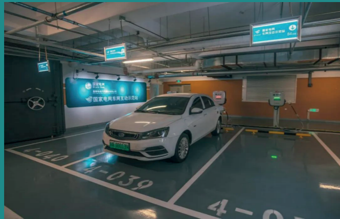
北京中再大厦V2G示范站 来源: 国网电动车公司
