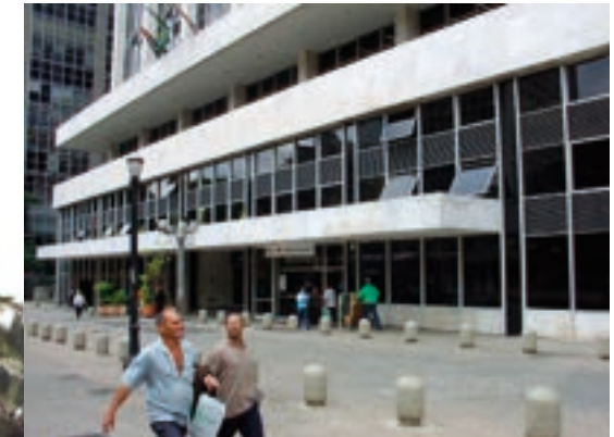
Existing situation Situação existente
