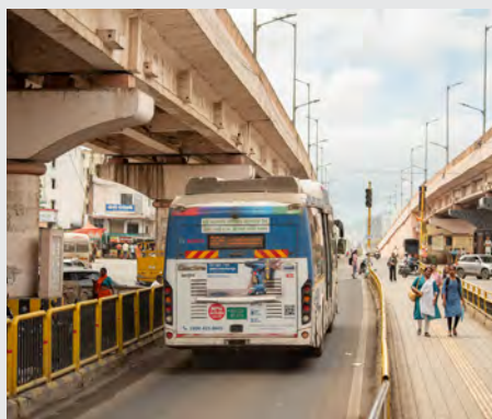
BRT Pune-Pimpri-Chinchwad en India. FUENTE: ITDP India.
