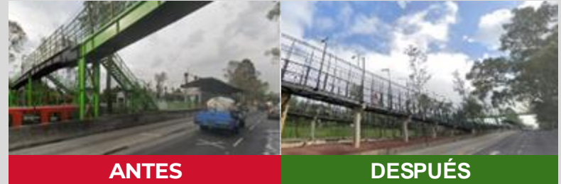
Sustitución de escaleras por rampa de acceso en la estación Euzkaro en el 2020
