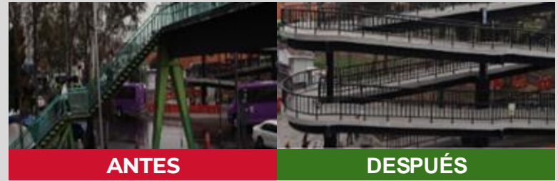
Adecuación de rampa de acceso en la estación La Raza y con conexión al Mexibús
