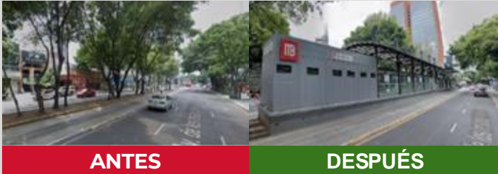
Construcción del cuerpo sur de la estación Félix Cuevas en el 2020
