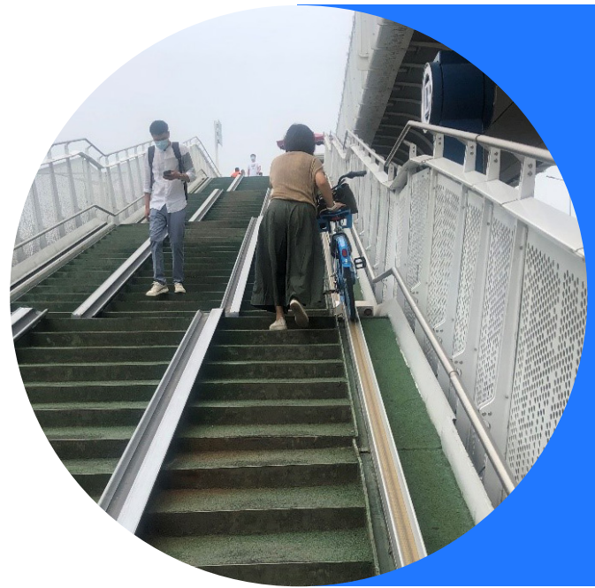
北京的自行车快速路高于街道,并在入口处设有楼梯和车轮坡道。 来源: ITDP China
